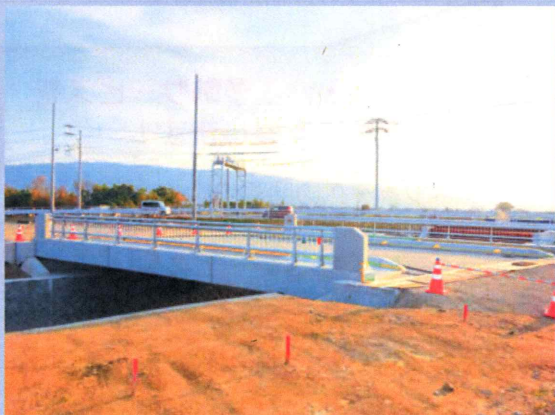
妙見橋 (国道386号古毛バス停付近)
