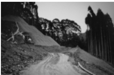
林道整備工事
