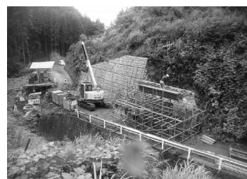
道路改良が進む山田・黒川線
