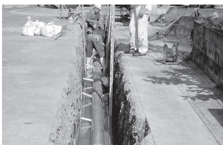
下水道管の埋設工事状況
