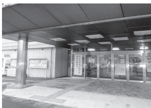
緩やかなスロープと音声誘導装置を付けた市役所北玄関
