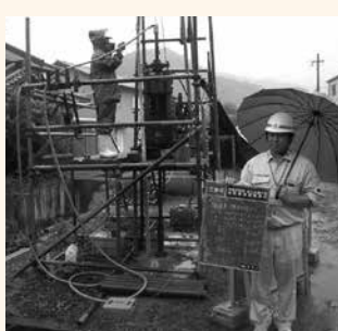
設計のための調査工事 実施の様子
