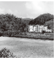
安全対策が急がれる下池田住宅・グラウンド
