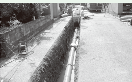
下水道管の埋設工事の様子
