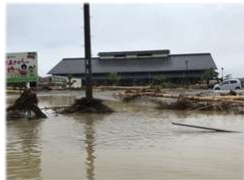
▲三連水車の里あさくら
