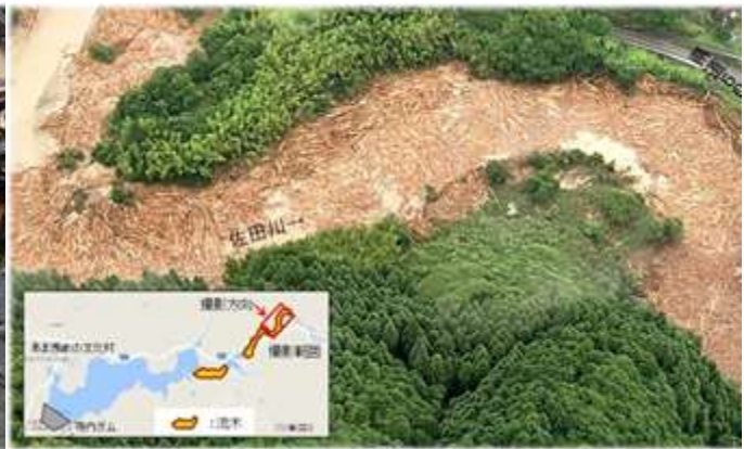
▲寺内ダム（流木と土砂の捕捉状況）
