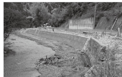
▲河川兼用護岸施工状況 [県道塔ノ瀬十文字小郡線 (朝倉市黒川)]
