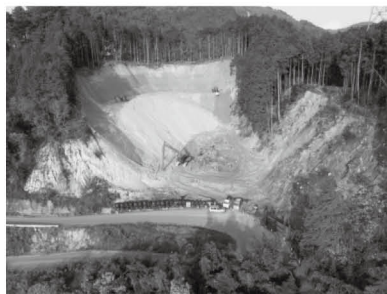
▲ 山腹工施工状況 (法面整形) [ 県道甘木吉井線沿 (杷木志波) ]
