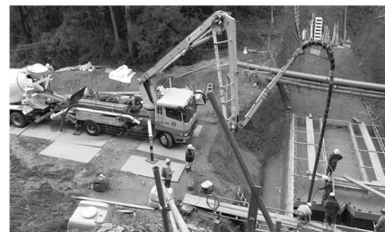
▲ 溪間工 (治山ダム) 施工状況 (コンクリート打設) [ 市道山田黒川線沿 (山田) ]
