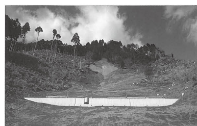
▲ 山腹工施工状況 [佐田彦道 (2) 地区]
