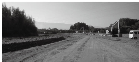
▲ 鎌塚ため池の復旧工事の様子
