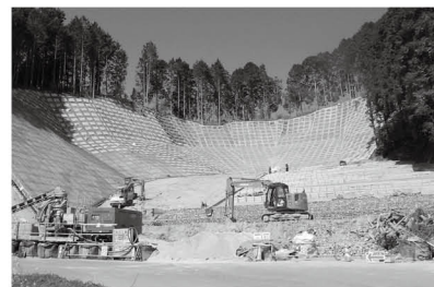
▲ 山腹工施工状況 [ 県道甘木吉井線沿（杷木志波） ]
