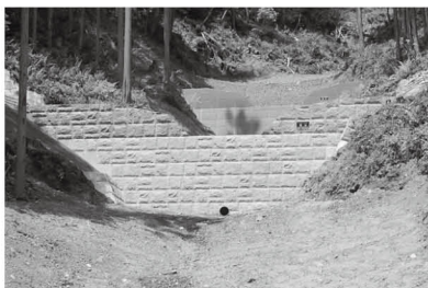
▲ 溪間工（治山ダム 2 基）完成状況 [ 県道 79 号線（須川） ]
