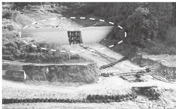
▲完成イメージ（石詰区砂防堰堤）
