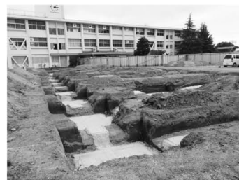
▲基礎部分の工事の様子
