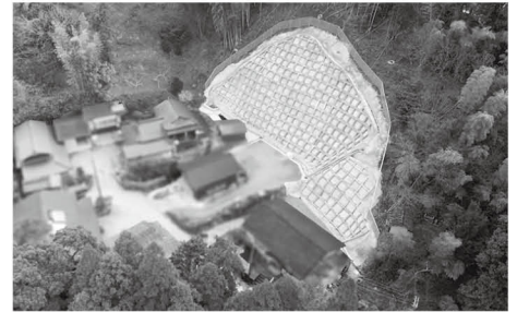
▲工事が完了した道目木 a -1 地区（杷木志波）
