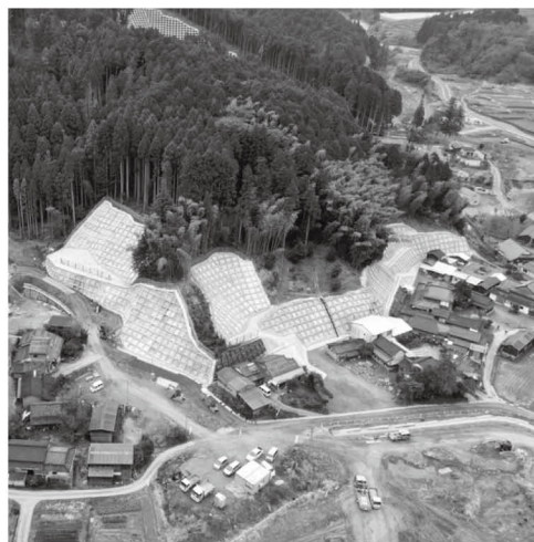
▲工事が完了した宮園地区（黒川）
