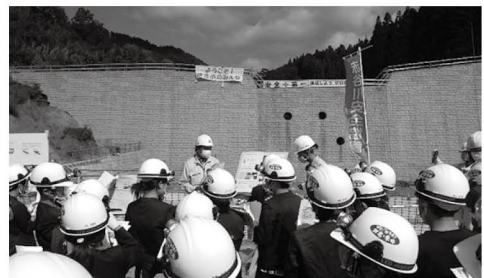
▲河川工事や砂防工事の現場を見学しました (写真は砂防工事見学の様子)
