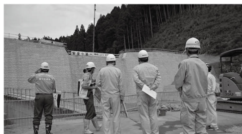
▲赤谷川流域の砂防工事の状況を確認する 林市長ら
