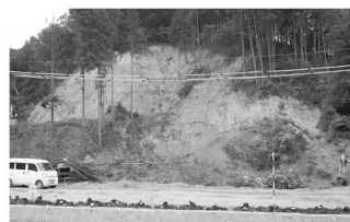
▲ 流木の撤去が完了(石詰)
