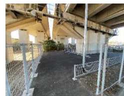
新設した駐車場
