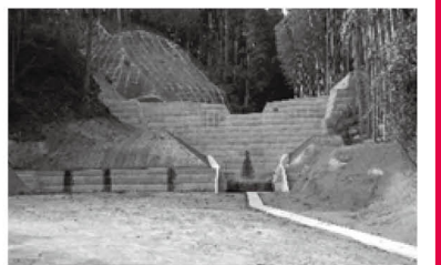
▲溪間工（治山ダム）完成状況（県道588号線沿 平覆公民館上流）
