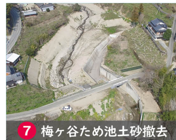
6 治山(山腹工)完成
