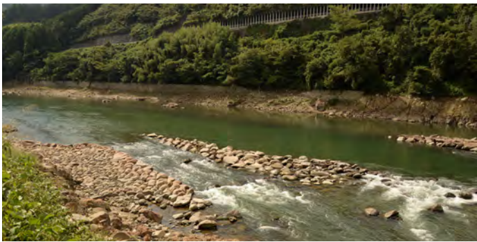
挿図4 姿を現した袋野堰(一部)
