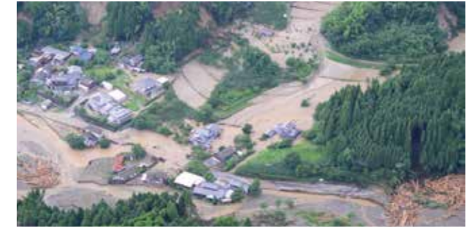
▼(上)崩谷川の被災直後(下)復旧後
