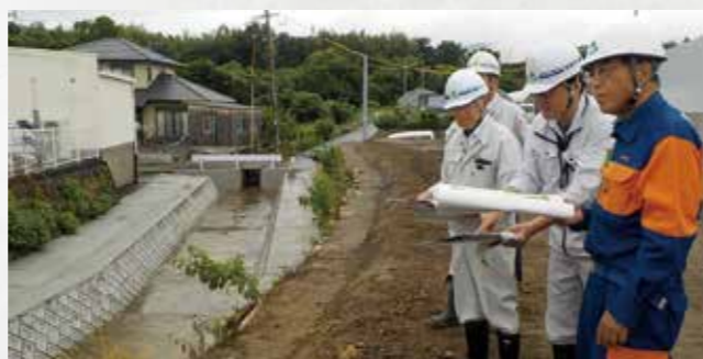
▲古毛地区の水路改良状況を確認
