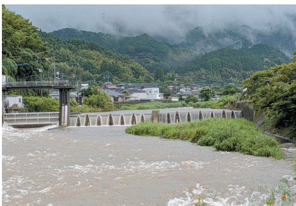
増水した女男石頭首工を望む
