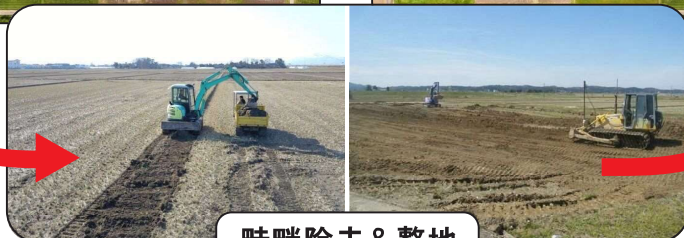
畦畔除去&整地
