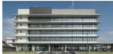
▲令和8年1月に開庁した新庁舎。基礎免震構造を採用し、防災拠点施設としての機能を維持します。
