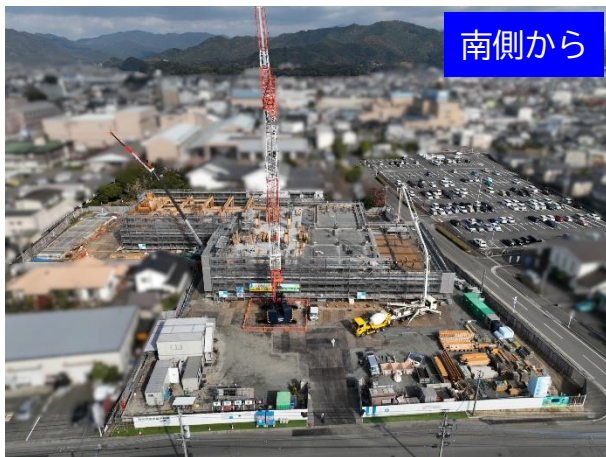
スラブ型枠状況（2階上部（3階床））
