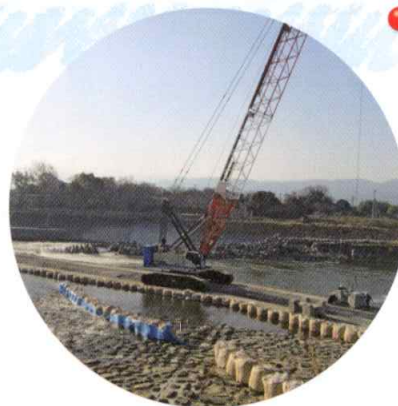
山田堰下流護床工事
