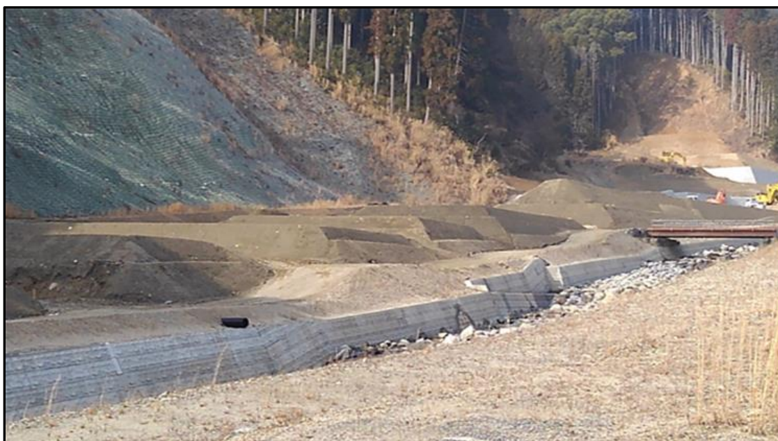
農地改良復旧事業の工事实施状況（松末 乙石川流域）
