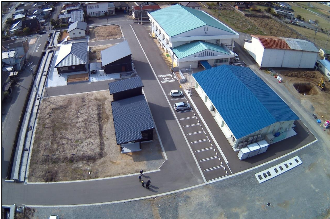
久喜宮小学校跡地の現況
