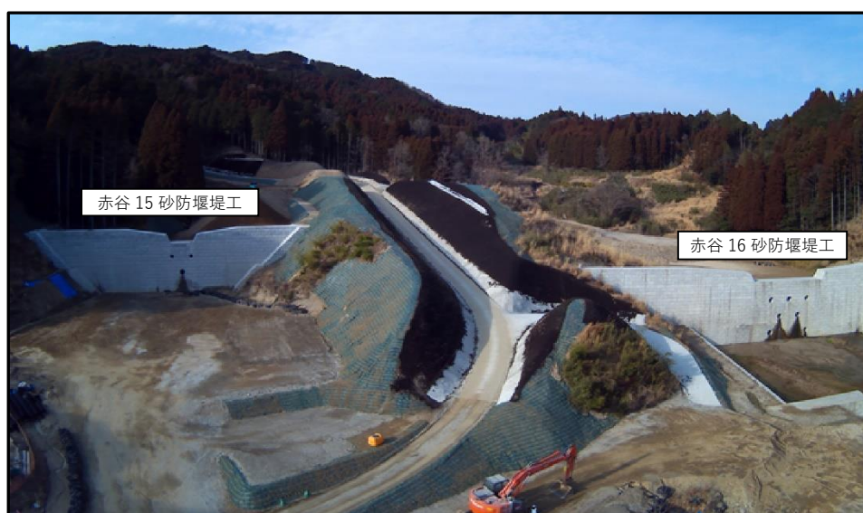
崩谷川砂防堰堤の現況
