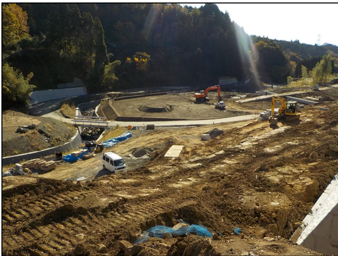
農地改良復旧事業の工事实施状況（高木 黒川地区）
