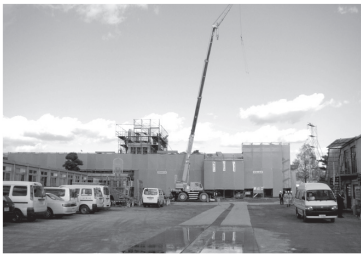
工事が進む馬田小学校
