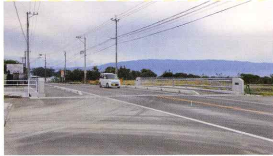
妙見橋(国道386号古毛バス停付近)
