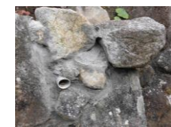
落石した石を修復
