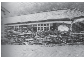
旧杷木町立原鶴中学校の校舎にぶつかったがれき類
