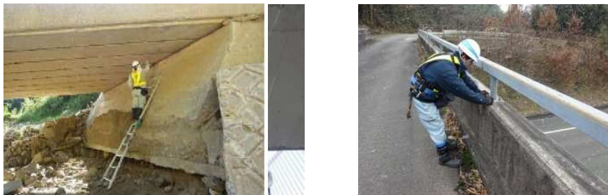
図-3 近接目視点検の様子
