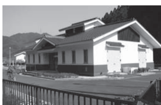
早急な下水道整備が望まれる
