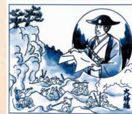
▲堀川の工事（水巻町教育委員会提供）
