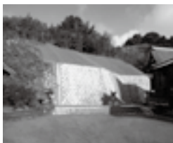
工事が完了した杷木白木地区
