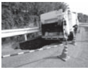
災害に強いまちづくりの取り組みを(道路陥没による車両事故)
