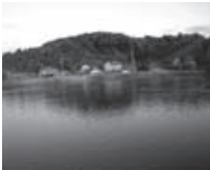
改修予定の上須川ため池
