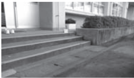
職員室前の階段 3段目まで水がきていた
