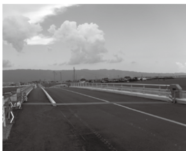
▲北側から見た乙王丸橋付近
