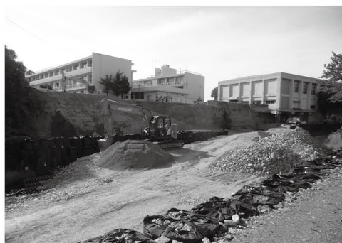
▲ 技術室棟の解体撤去 (5月24日撮影)
