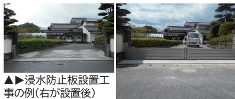
▲▶ 浸水防止板設置工事の例(右が設置後)
