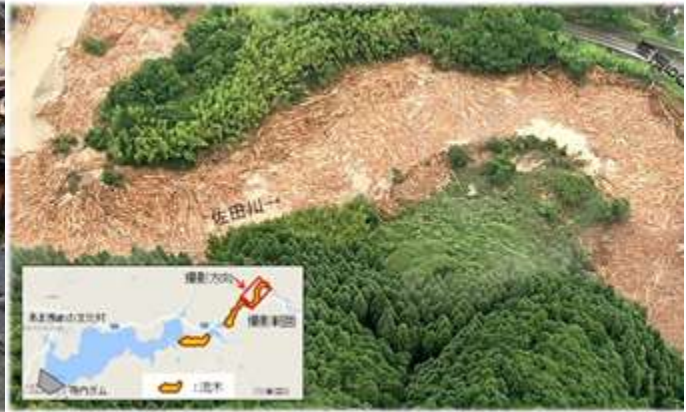
▲ 寺内ダム（流木と土砂の捕捉状況） （出典：独立行政法人水資源機構）
