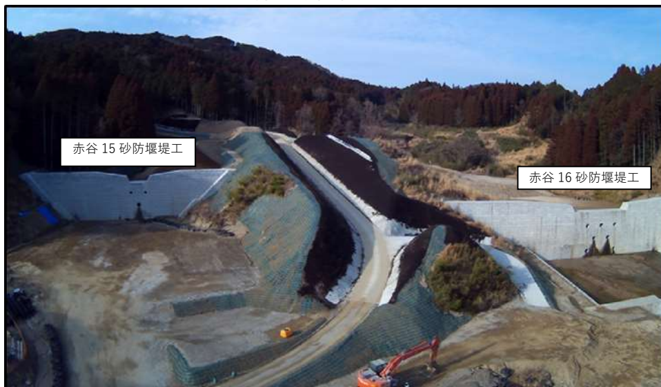
崩谷川砂防堰堤の現況
