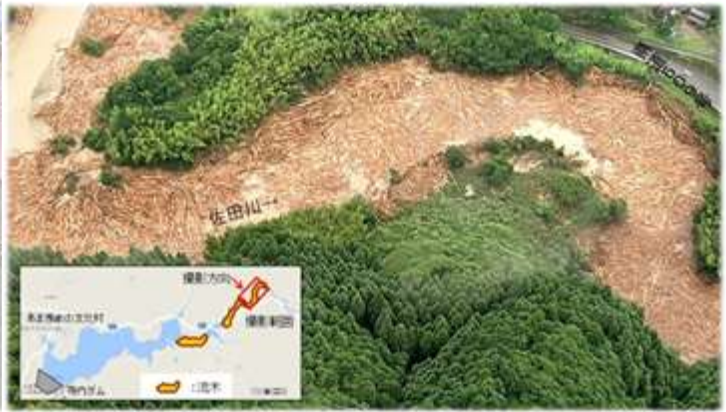
寺内ダム（流木と土砂の捕捉状況）
