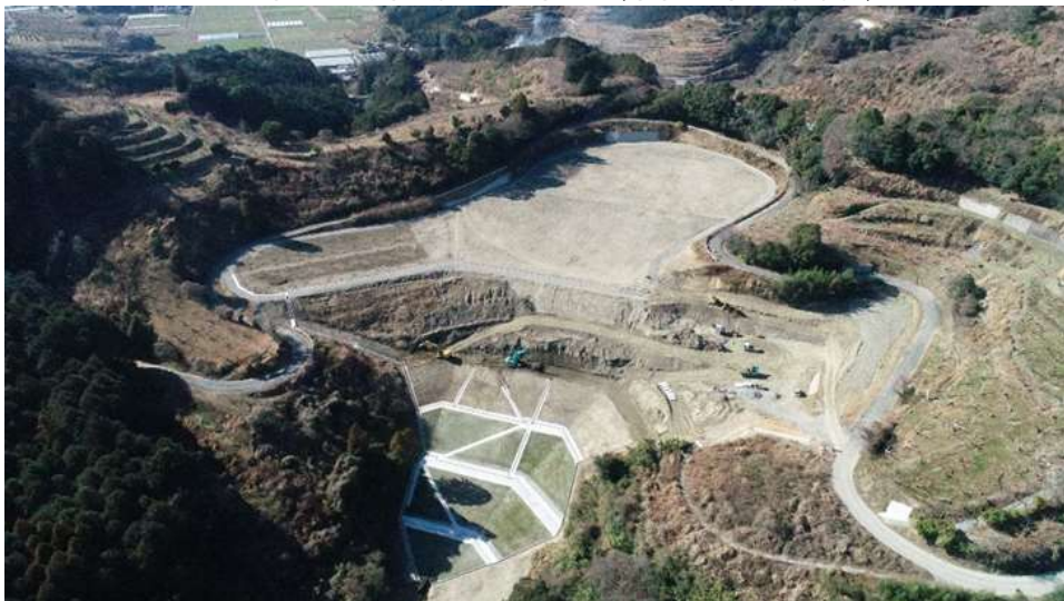
宮野土砂置場の現地状況 (令和4年1月撮影)
