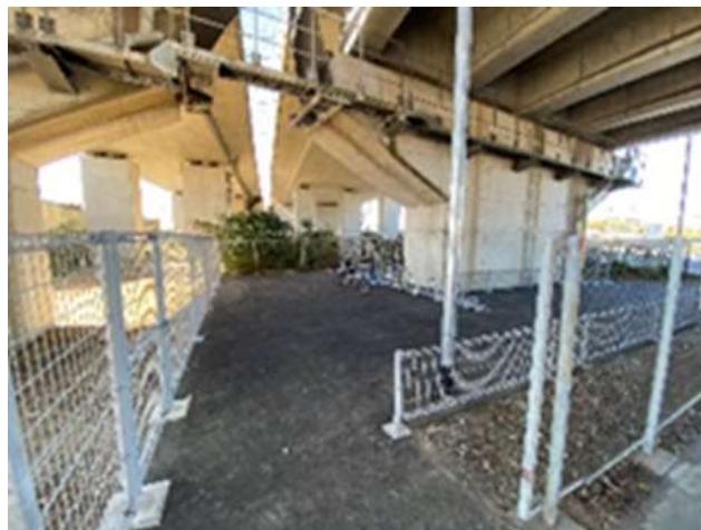
新設した駐輪場
