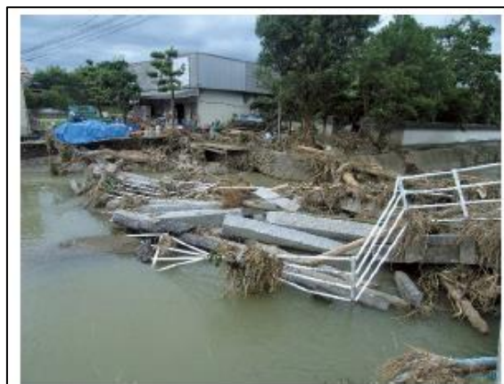
久保島の石造桁橋 被災状況
