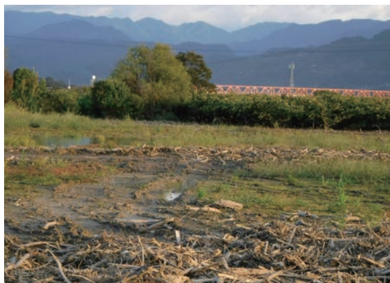
写真-5.3.11 平野部排土工(施工前)
