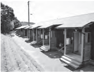
応急仮設住宅 (建設型)
