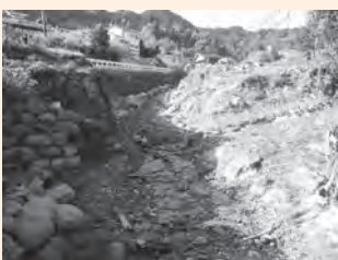
災害復旧工事を行う平川
