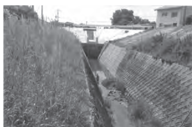
被災後完成した長田川排水門
